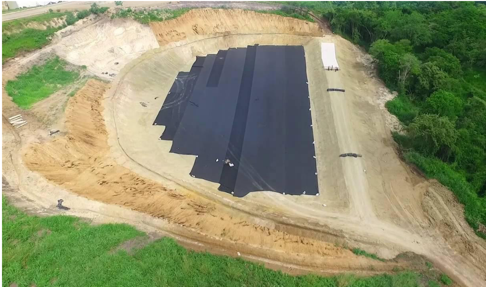
Relleno de seguridad
